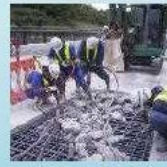
▲修繕・耐震補強
